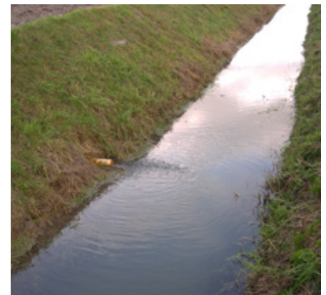
Een goede afwatering wordt bevorderd door goed werkende drainagebuizen. Zorg dus dat de eindbuis open is. Spuit eventueel de drainagebuizen tijdig door.
